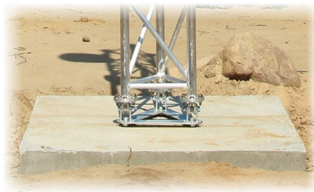
Vista della piastra di fondazione e del sistema di fissaggio al suolo. La piastra sarà elitrasportabile per una efficiente gestione ed un'eventuale ricollocamento della stazione.
